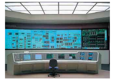
3・4号機用新型中央制御盤のモデル
