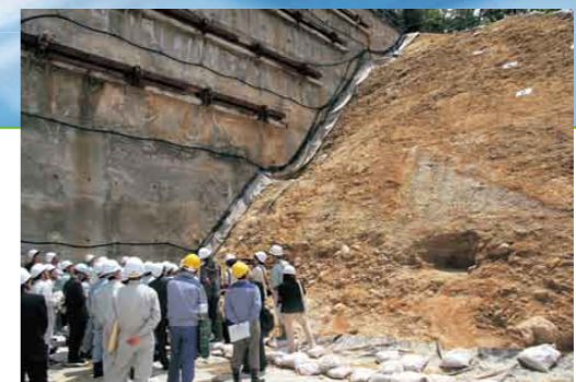
耐震安全性評価の現地調査
