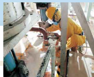
タービン主要弁廻りの解体作業
