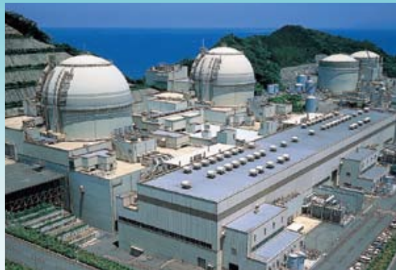
かんさいでんりよくがぶつおひはつでんしよ 関西電力株式会社大飯発電所
