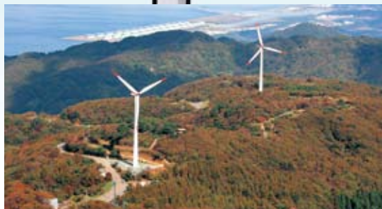
くにみだけふうりょくはつでんしよ ふくいけんふくいし 国見岳風力発電所(福井県福井市)
