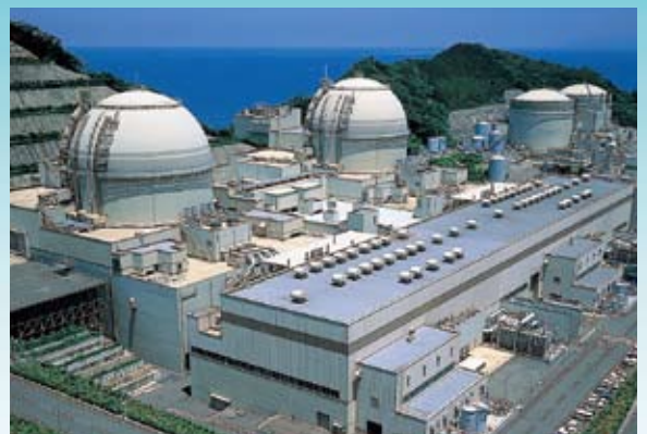
かんさいでんりよくがぶつおなごうはつでんしよ 関西電力株式会社大飯発電所
